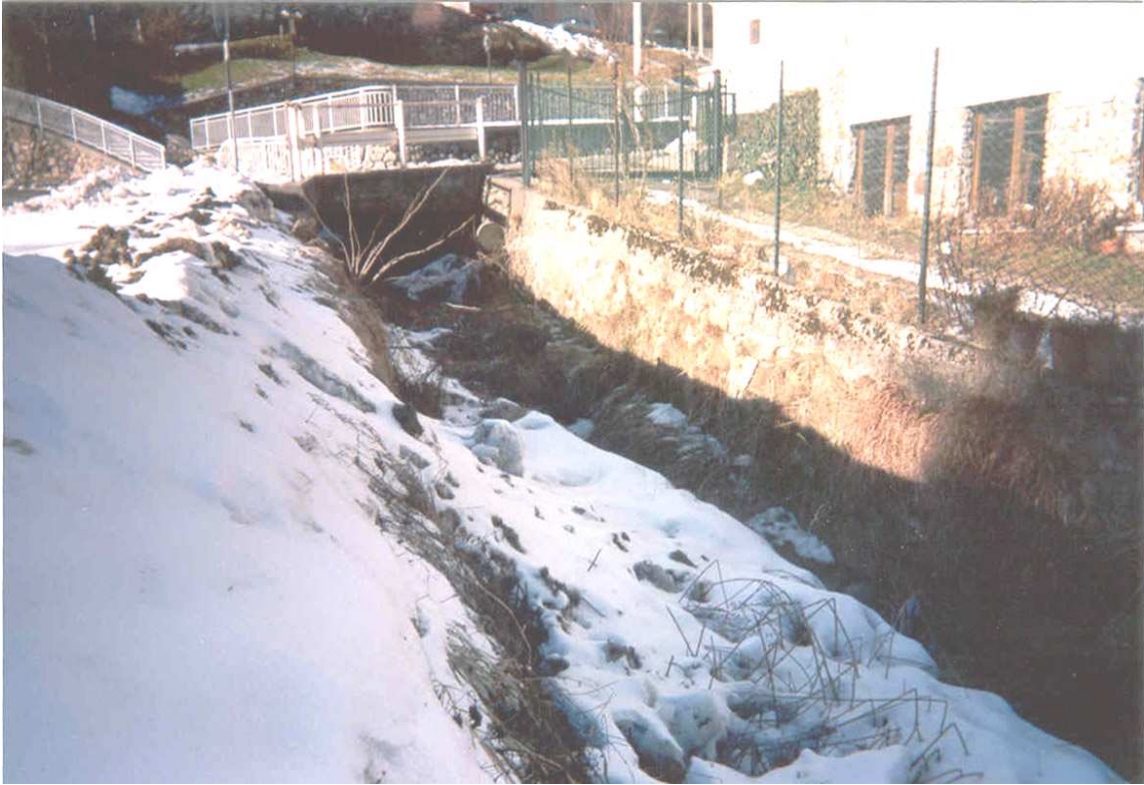
Foto 1 - Corso d'acqua nei pressi della chiesa di Casargo ricoperto da materiale vegetale e sovralluvionamento in alveo.
