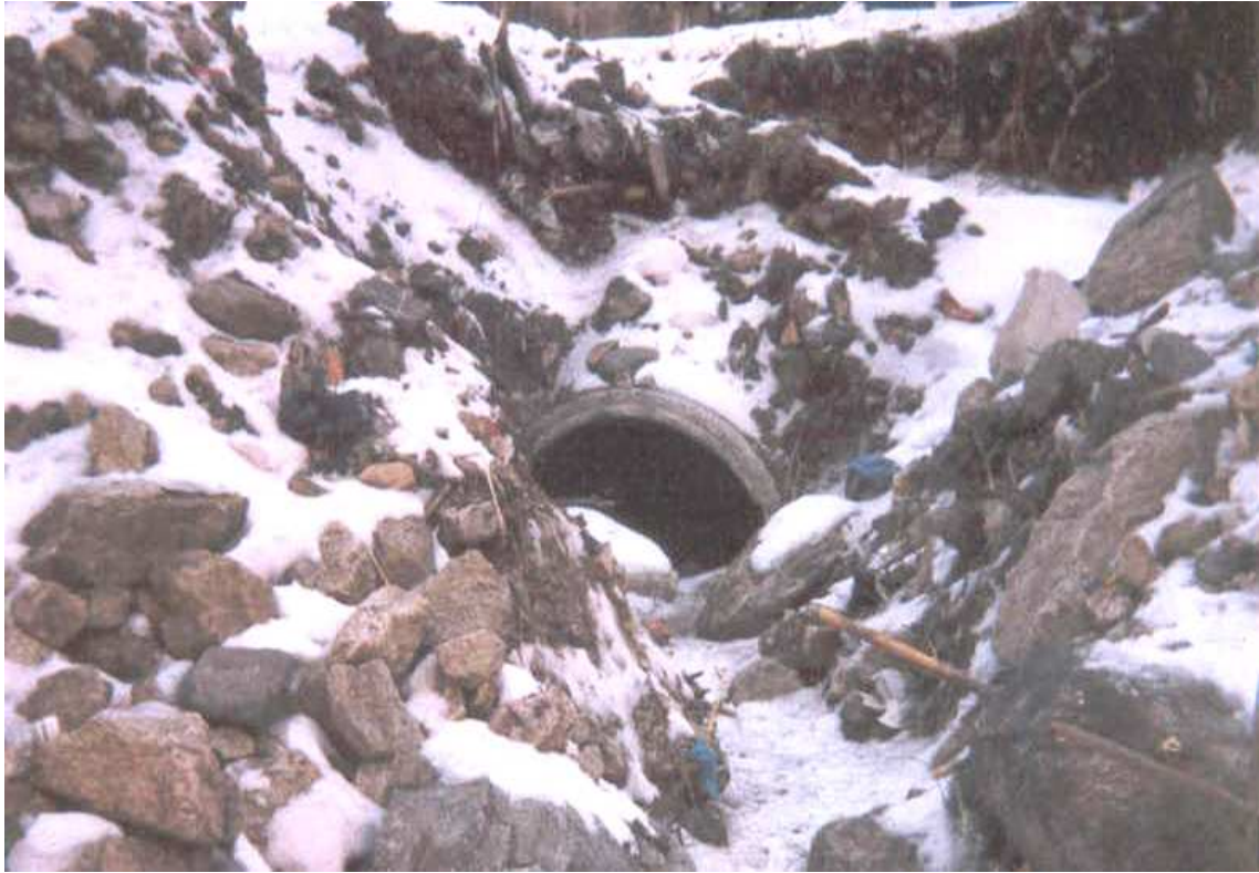
Foto 3 - Sovralluvionamento con materiale grossolano all'uscita di un tombotto sulla S.P. 67 .
